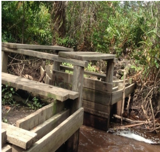
Gambar 1. Salah satu bentuk sekat kanal di Dusun 1 oleh BRG dan WALHI
